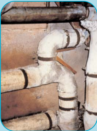
Asbestos pipe lagging
